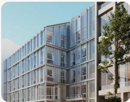
Immeuble le Rivoli à Issy-les-Moulineaux
