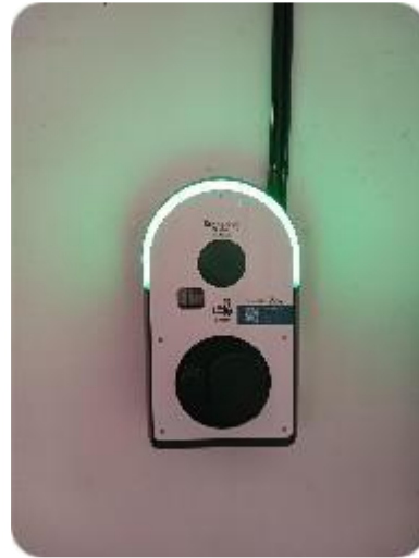
Installation de 20 bornes sur l'actif Lugdunum à Lyon.
